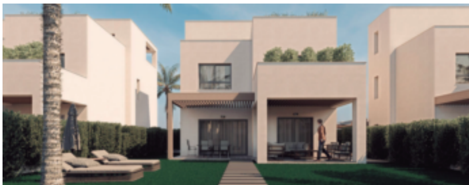
Imagen de uno de los 53 chalets que la Confederación impulsa en Vera, Almería.
