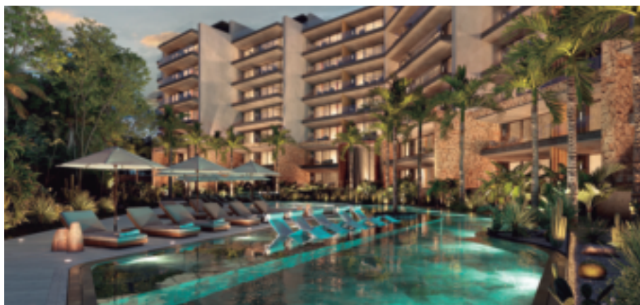
Distrito Xcalacoco Beach, en la Riviera Maya, otro de los proyectos emblemáticos.
