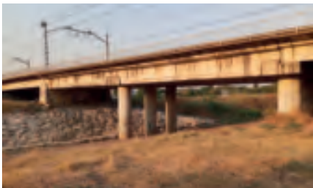
Viaducto ferroviario sobre el que trabajará Fonsán en Sevilla.
